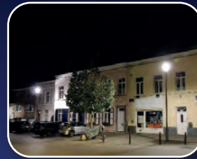
À droite, luminaire remplacé, peu de diffusion vers les fenêtres et aucune vers le ciel. À gauche, ancien luminaire avec diffusion vers les fenêtres et vers le ciel
